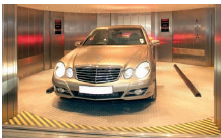
Kabine des Automobil-Aufzugs
